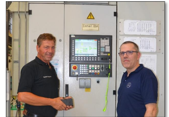
Cut-Check-Stick am Siemens Steuerungsmodul der Heller BAZ.
